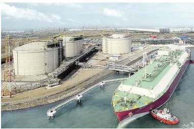
Un deposito costiero simile a quello progettato da Edison
